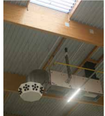
Le système à jets à induction Smitsair optimise la distribution de l'air dans les bâtiments industriels.
