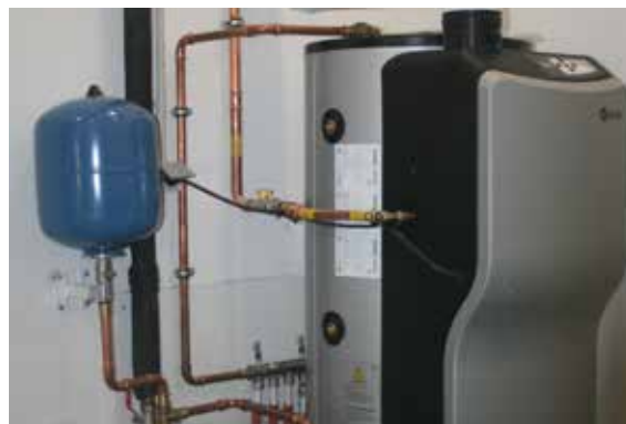
Le boiler au gaz à condensation à haut rendement entièrement fermé Innovo d'A.O. Smith se situe dans le segment des petites puissances avec moins de 30 kW.
